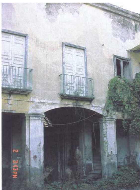
Veduta dell'androne d'ingresso dall'interno del cortile
