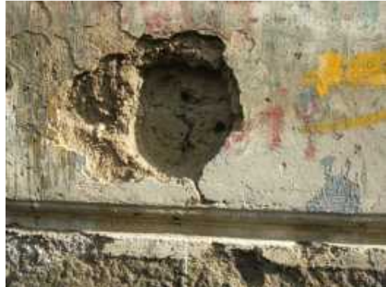
Particolari del tratto murario prospiciente via Riscatto: si notino i conci di pietra di tufo a forma irregolare
