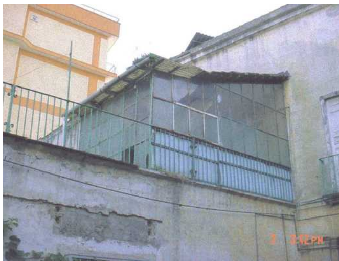
Veduta dell’angolo tra il fabbricato e l’inizio della terrazza (si noti una superfetazione costituita dalla veranda in ferro e vetro con copertura in lamiera di fibra di vetro)
