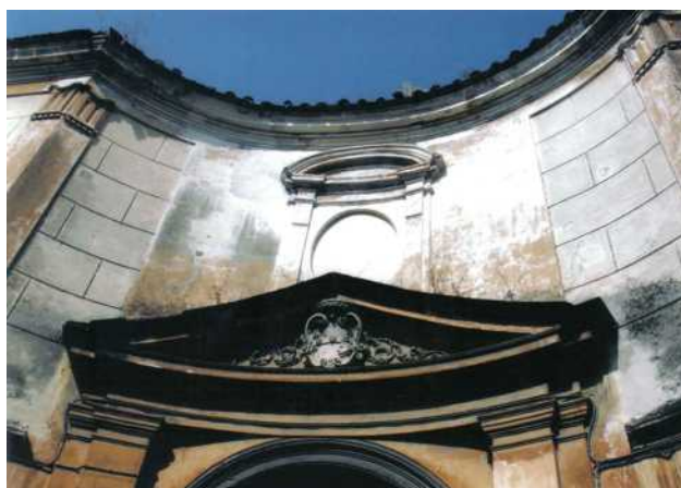
Il timpano sul portale d'ingresso principale
