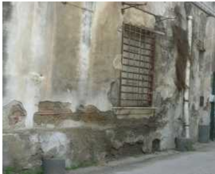
Particolare del tratto murario prospiciente Traversa Riscatto: si notino i conci di pietra di tufo a forma regolare ed i rinforzi orizzontali in mattoni di laterizio inesistenti nei restanti muri
