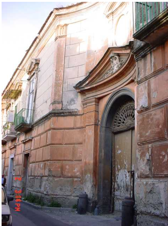
Vista del prospetto principale del palazzo della Gran Corte della Vicaria
