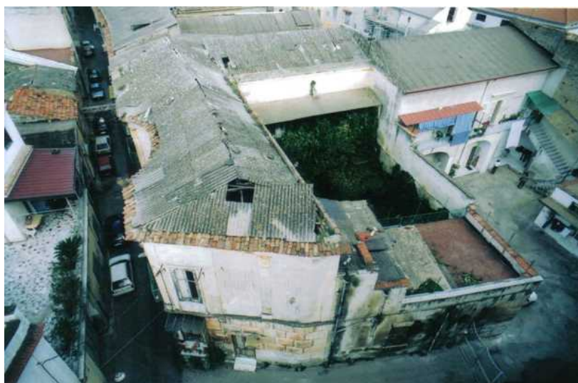
Veduta dall'alto del palazzo della Gran Corte della Vicaria (si noti l'inclinazione anomala tra le mura dell'angolo stradale)
