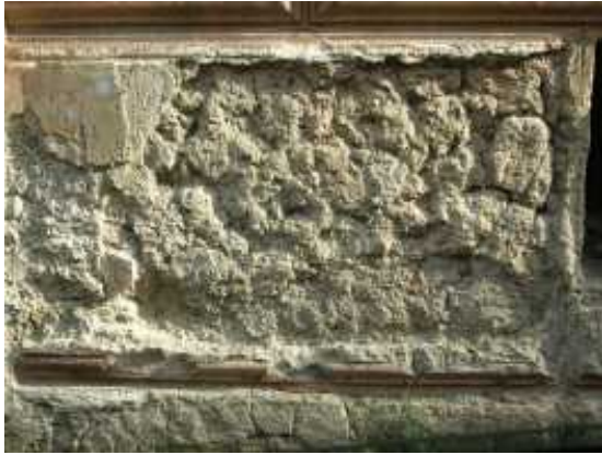
Particolari del tratto murario prospiciente via Riscatto: si notino i conci di pietra di tufo a forma irregolare
